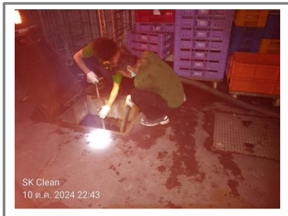
รูปที่ 3-25 สุกตะกอนจากระบบบำบัดน้ำเสีย
