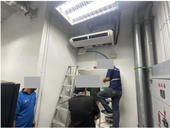
รูปที่ 3-95 การทำความสะอาดเครื่องปรับอากาศ ภายในโครงการ
