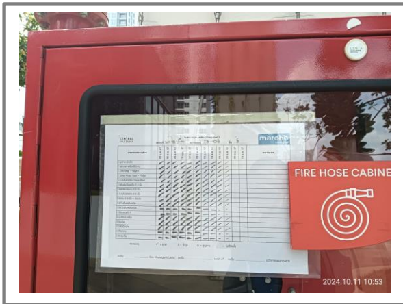
รูปที่ 3-90 การตรวจสอบสภาพอุปกรณ์ป้องกันและระงับอัคคีภัย
