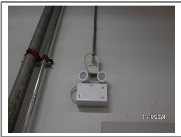
รูปที่ 3-84 ไฟส่องสว่างฉุกเฉิน
