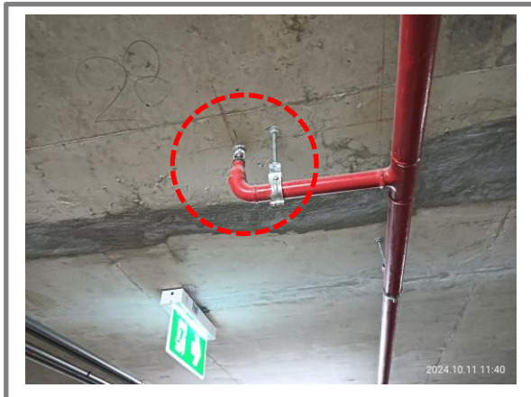
รูปที่ 3-85 หัวกระจายน้ำอัตโนมัติ
