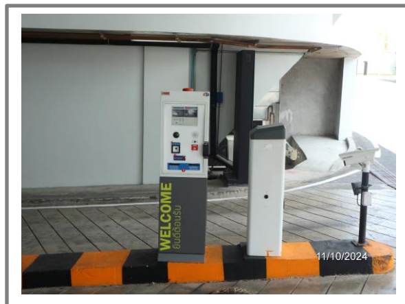
รูปที่ 3-37 เครื่องจ่ายบัตรจอดรถอัตโนมัติ
