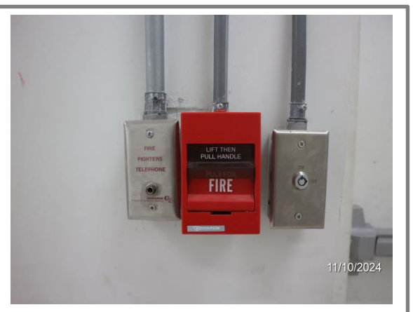
รูปที่ 3-83 เครื่องแจ้งเหตุโดยใช่มือดึง และตัวรับโทรศัพท์แจ้งเหตุเพลิงไหม้
