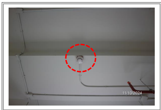
รูปที่ 2-23 เครื่องตรวจจับควัน
