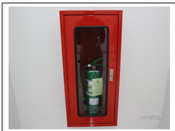
รูปที่ 3-75 ตู้เก็บถังดับเพลิงแบบมือถือ
