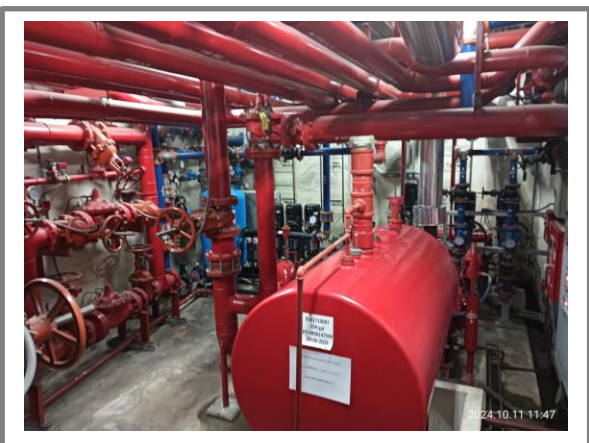
รูปที่ 3-80 ระบบปั้มน้ำดับเพลิง
