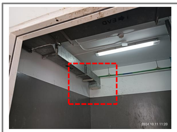
รูปที่ 3-49 ท่อระบายอากาศจากห้องพักขยะเปียก
