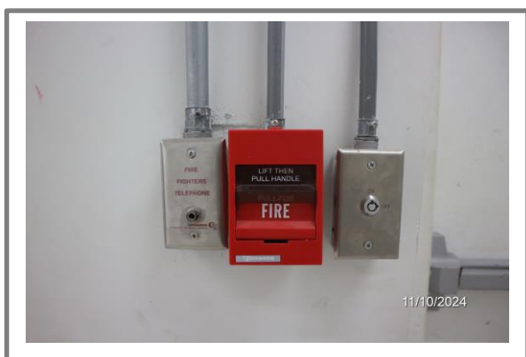
รูปที่ 2-25 ตัวตั้งสัญญาณเตือนอัคคีภัย
