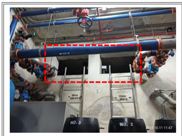
รูปที่ 2-5 ถังเก็บน้ำสำรองบริเวณชั้นใต้ดิน
