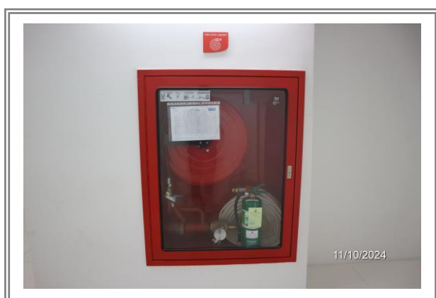
รูปที่ 2-19 ตู้เก็บสายฉีดน้ำดับเพลิงพร้อมอุปกรณ์
